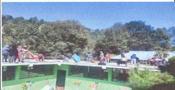
Foto 1: Mejoramiento de losa con pañuelos de tipo impermeabilizante
