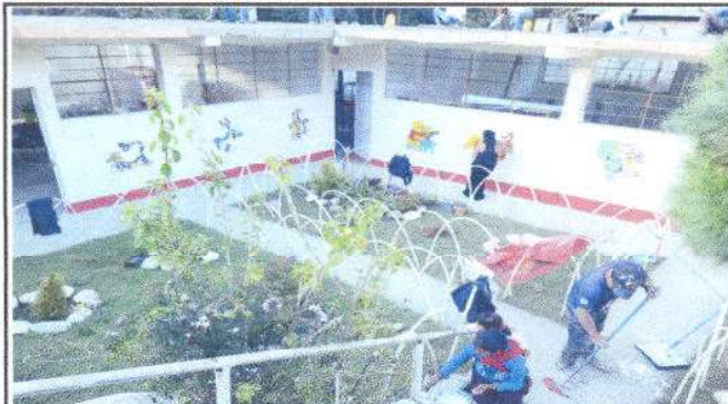
Foto 8: Pintura en muros exteriores e interiores
