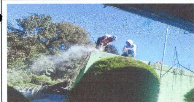
Foto 5: Impermeabilización de losa y bajadas de agua pvc
