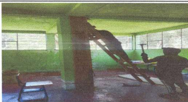
Foto 6: Mejoramiento de losa con reforzamiento interno
