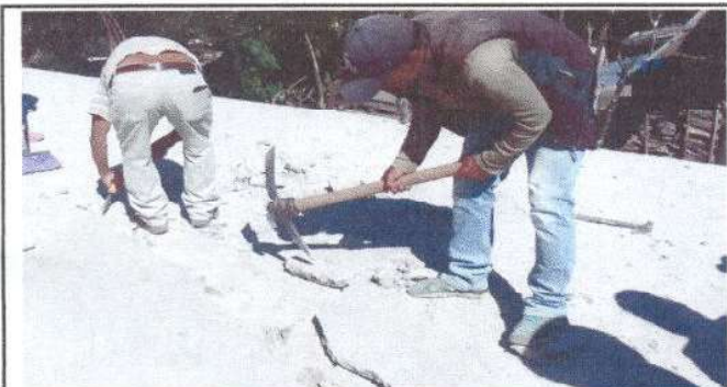
Foto 3: Impermeabilización de losa, raspado exterior
