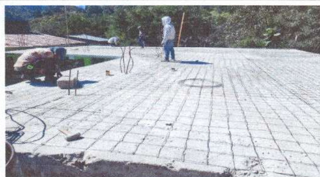
Foto 4: Impermeabilización de losa, electromalla de 1/4 y aplicación de impermeabilizante
