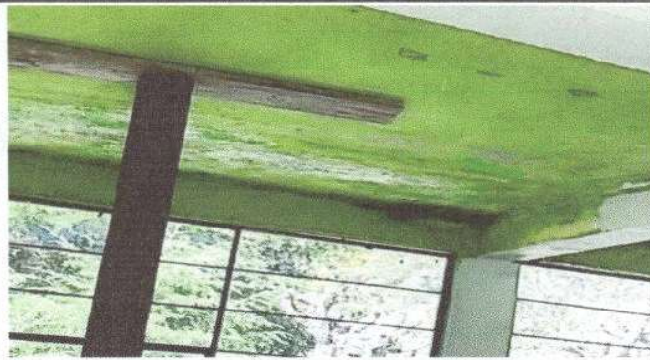
Foto 2: Impermeabilización de losa raspado interior
